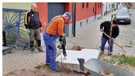
Das Hoymer KUF24 bekommt ein neues Tor. FOTO: DENKMALSCHUTZVEREIN/KIENAST
